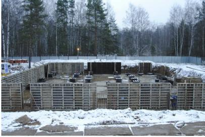
В жилом комплексе "Вега" уже залиты фундаментные плиты под все 3 дома. Наши рабочие занимаются устройством стен цокольного этажа (подвала). В данный момент ведется монтаж конструкций подвала ниже отметки "0" (первого этажа). Уже сейчас видно, как дом начинает расти. Посмотреть фотографии, узнать подробную информацию
