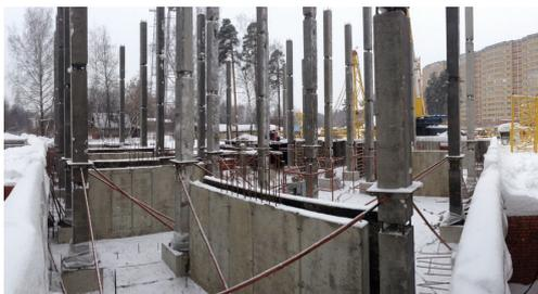
Дом №3. Начался монтаж этажей. Смонтированы четырехъярусные колонны в количестве 41 штуки для возведения дома. Смонтирована 1/3 перекрытий подвала. Монолитные работы и кирпичная кладка подвала завершены. На [страничке ЖК "Вега"](#) вы можете посмотреть как это происходит. Так же строители заканчивают монтаж башенного крана.
